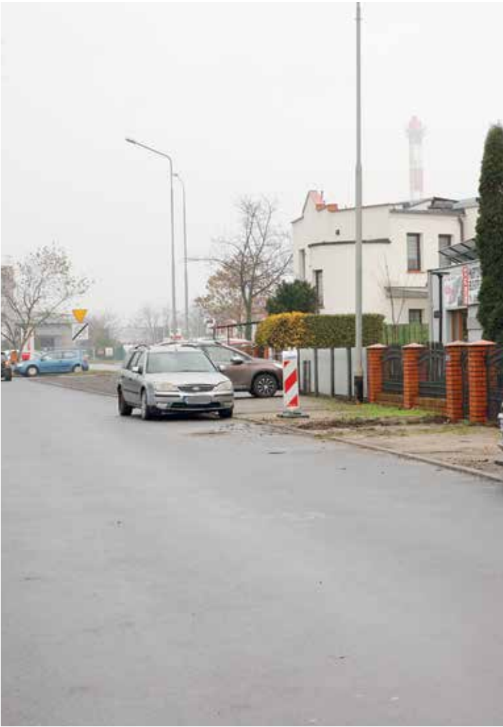
Budowany chodnik przy ul. Warsztatowej ułatwi komunikację i zwiększy bezpieczeństwo w tym rejonie.
