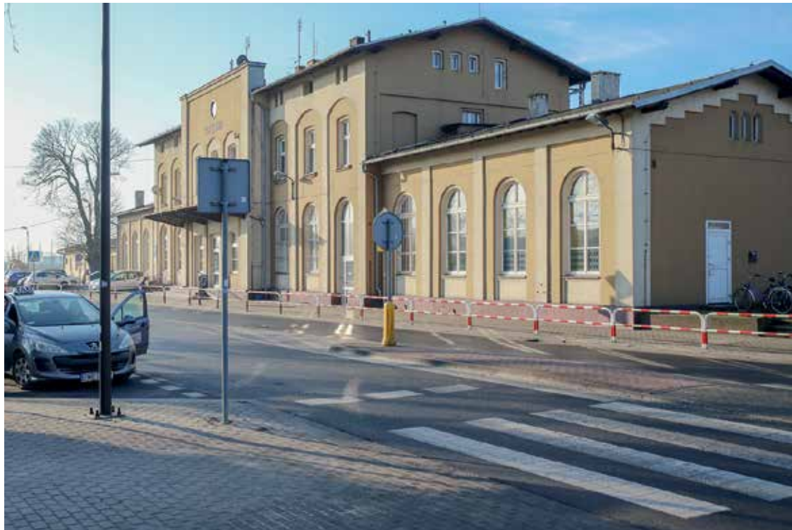
Remont dworca PKP został ujęty w Programie Inwestycji Dworcowych na lata 2024 - 2030.
