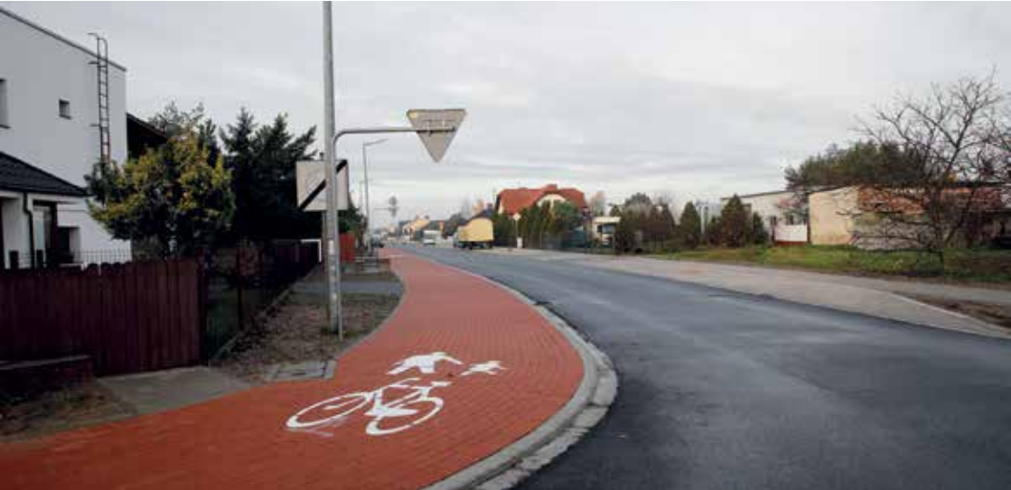
Obecnie na terenie inwestycji trwają prace porządkowe.
