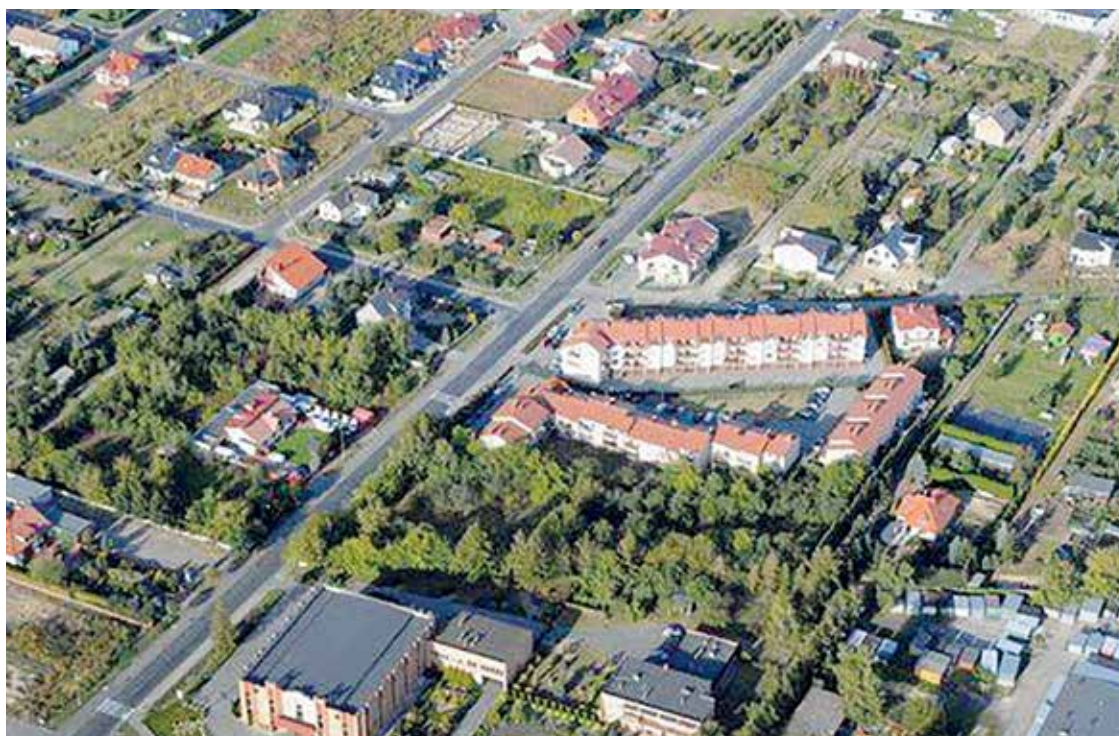
Ulice Owocowa i Ignacego Kujawy doczekają się przebudowy.
