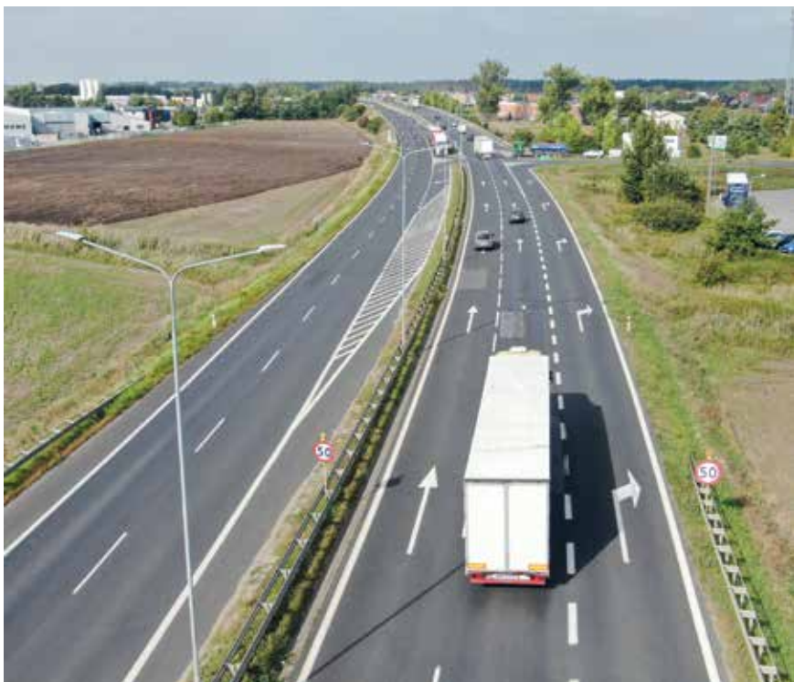
Zdjęcie nr 1- ograniczenie prędkości 50 km/h na drodze krajowej nr 92 przy zjeździe do Wrześni.
