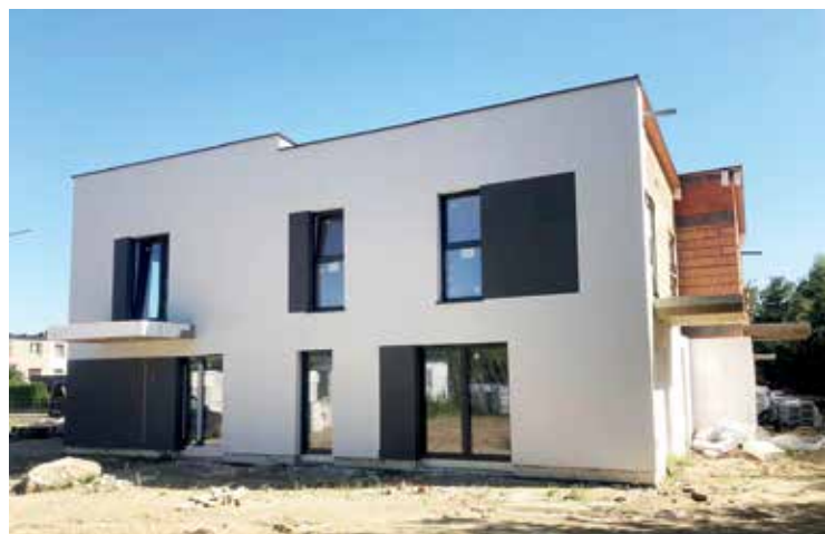
Powstający budynek przy ul. Piłskiej.
