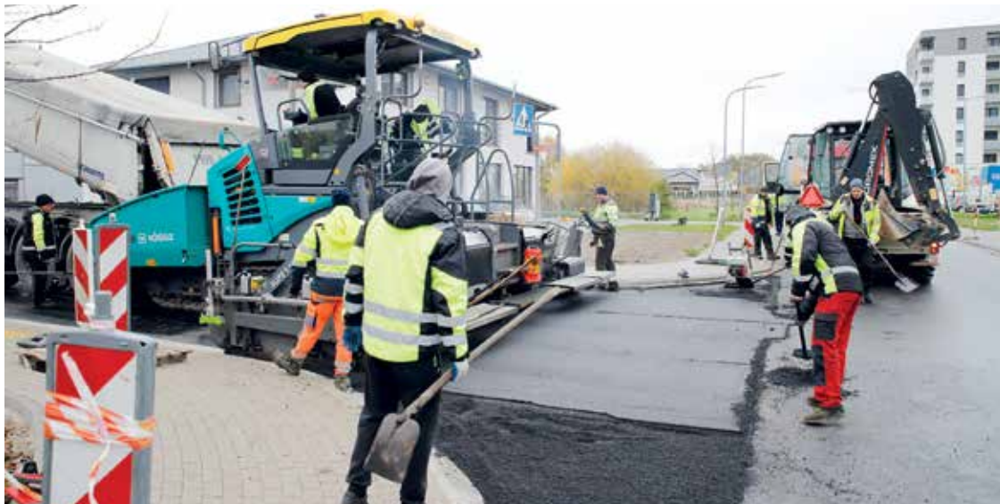
Kładzona warstwa asfaltowa przy ul. Jana Bartkowiaka.
