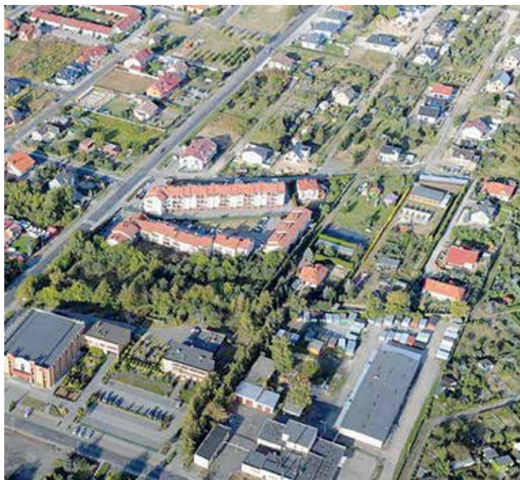
Ulice Owocowa i Ignacego Kujawy doczekają się przebudowy.
